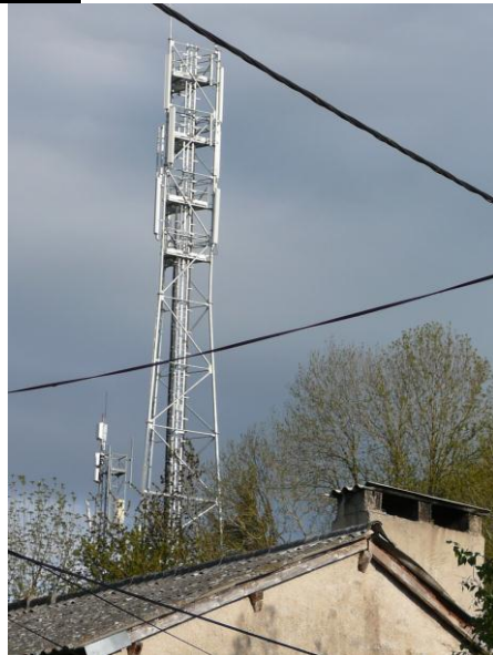
maison P depuis fenêtre chambre maison B
